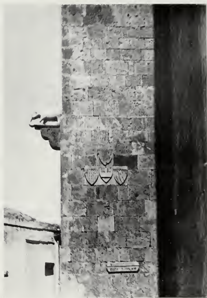
Cagliari - Torre dell'Elefante (particolari).
